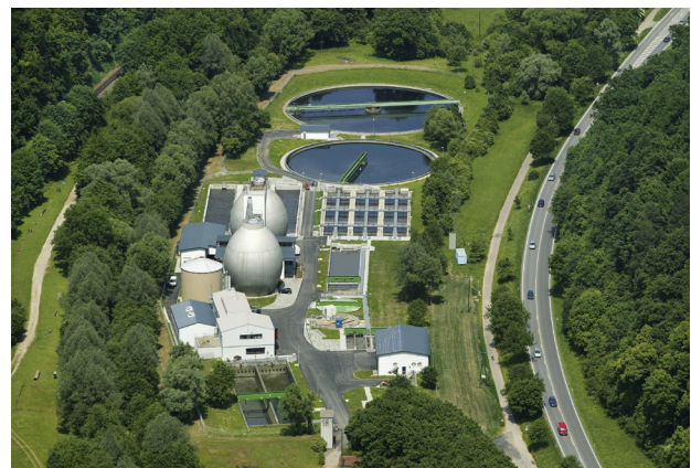
Luftbild des Klärwerks Dusslingen
